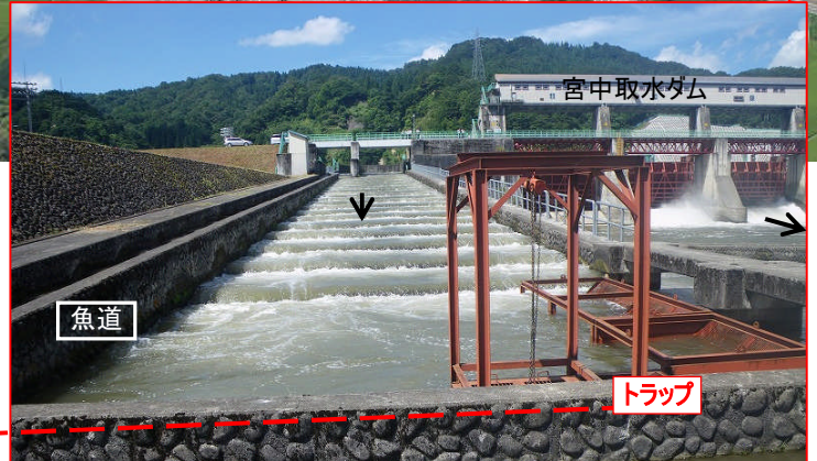
平成22年のサケ遡上状況調査におけるトラップ設置状況
