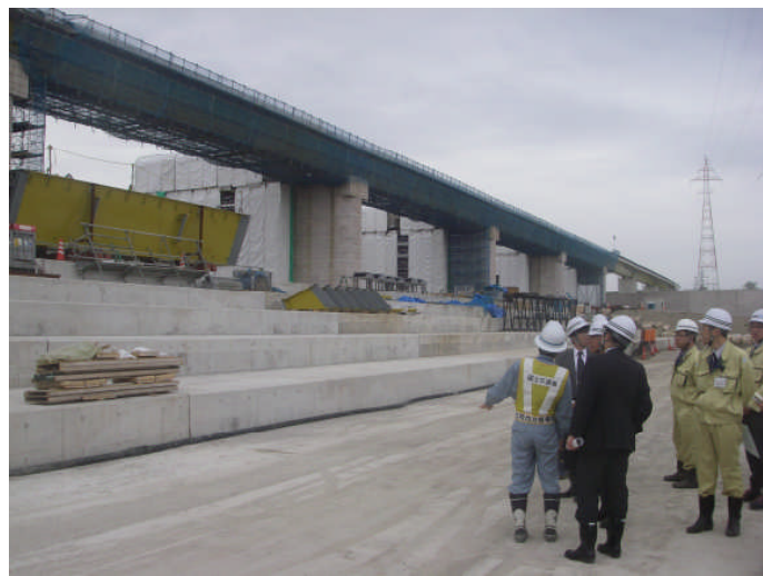
可動堰本体工事現場視察状況
