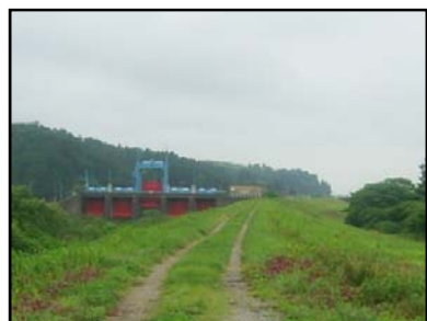
堤防天端舗装前
