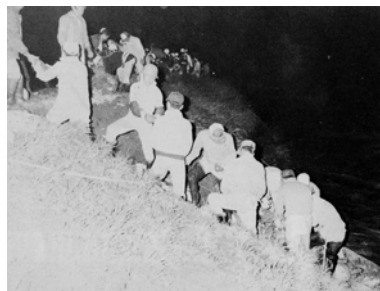
昼夜を分かたず実施された水防作業 昭和 58 年 9 月 十日町市城之古地先
