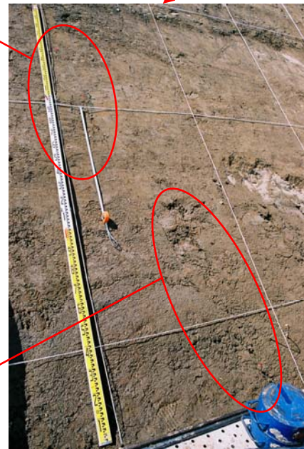
堤体の陥没により発生した亀裂に液状化した砂（暗灰色）の貫入が認められる
