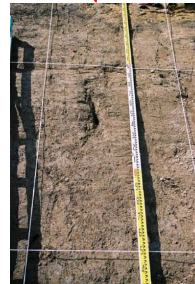
小段下部の亀裂
