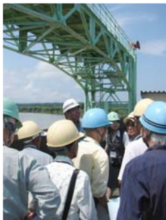
現在の可動堰の老朽化の状況を間近で見ている様子。
