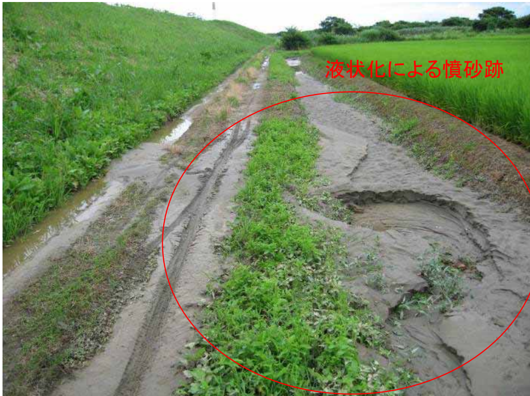
【堤防前面の液状化】
