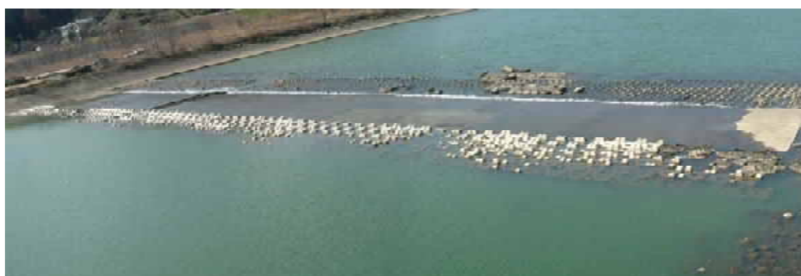
工事完成状況
