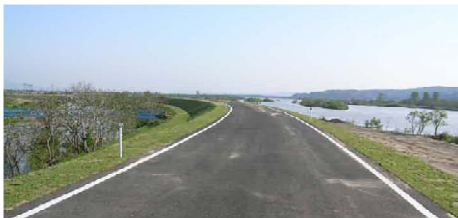
工事完成状況
