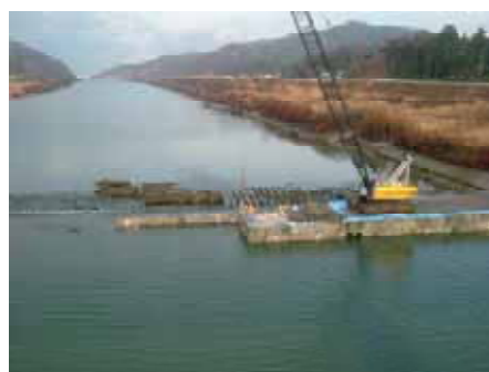
工事施工状況
