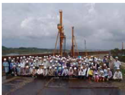
写真左 地盤改良工 (無震動工法)
