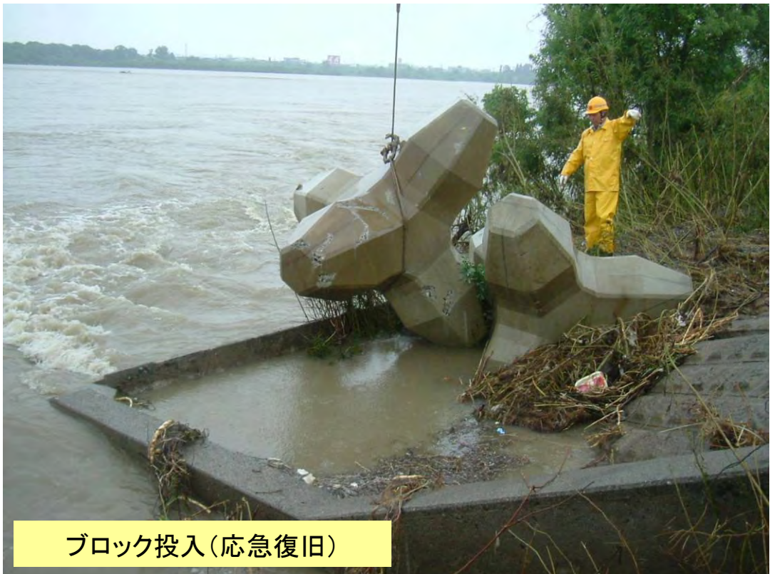
長岡市大宮地先【護岸の欠壊】
