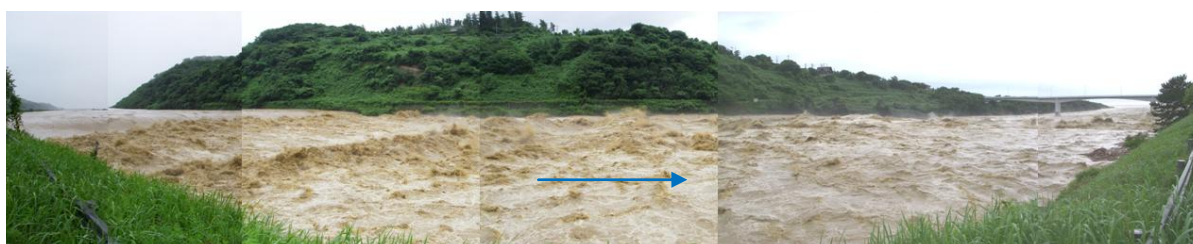
平成 23 年 7 月洪水時の第二床固付近の状況
