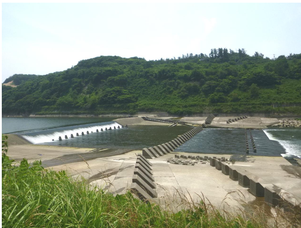
写真 第二床固（平成 27 年 6 月撮影）
