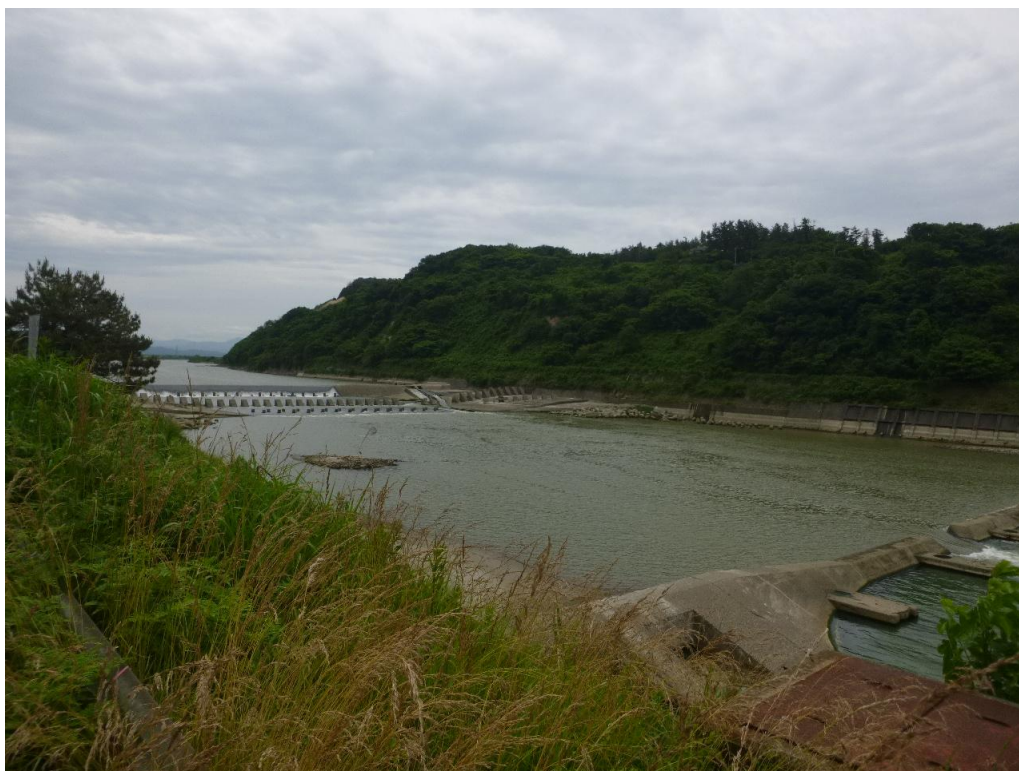
写真 第二床固工の現在（平成 27 年 6 月撮影）
