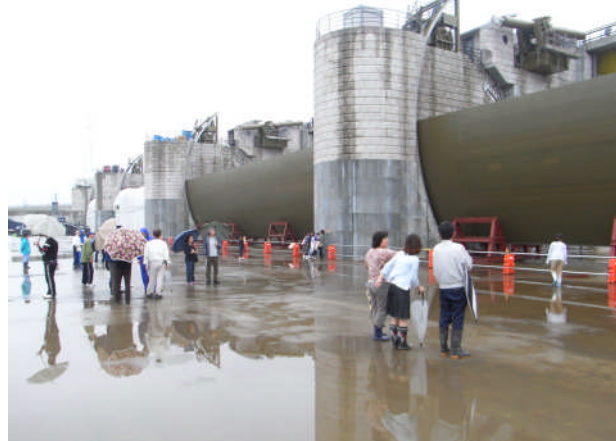
ラジアルゲート、堰柱を見学する見学者
