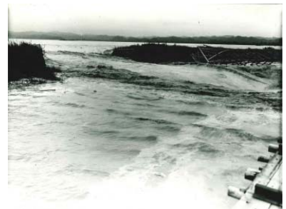
洪水のため可動堰仮締切りを切り 分水路に水を流しました。 撮影：昭和5年8月2日
