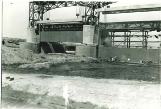
可動堰9・10径間附近の鋼扉、対重、管理橋上部、捲揚機の試運転の状況 撮影：昭和6年3月30日 新潟市渡部猛氏寄贈
