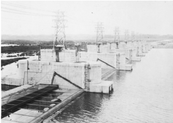
完成直前の自在堰
