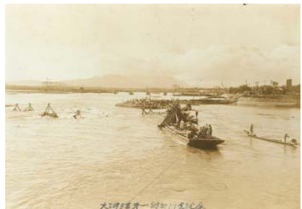
仮締切り堤防建設のための川倉沈床の設置 燕市古澤清治氏寄贈
