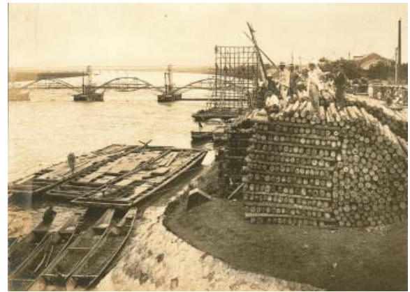
右岸に積み上げられた足場用と推測される資材 燕市古澤清治氏寄贈
