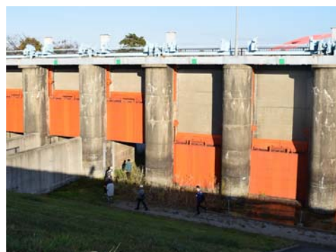
登録有形文化財「洗堰」をくぐり、洗堰の構造なども解説しました。
