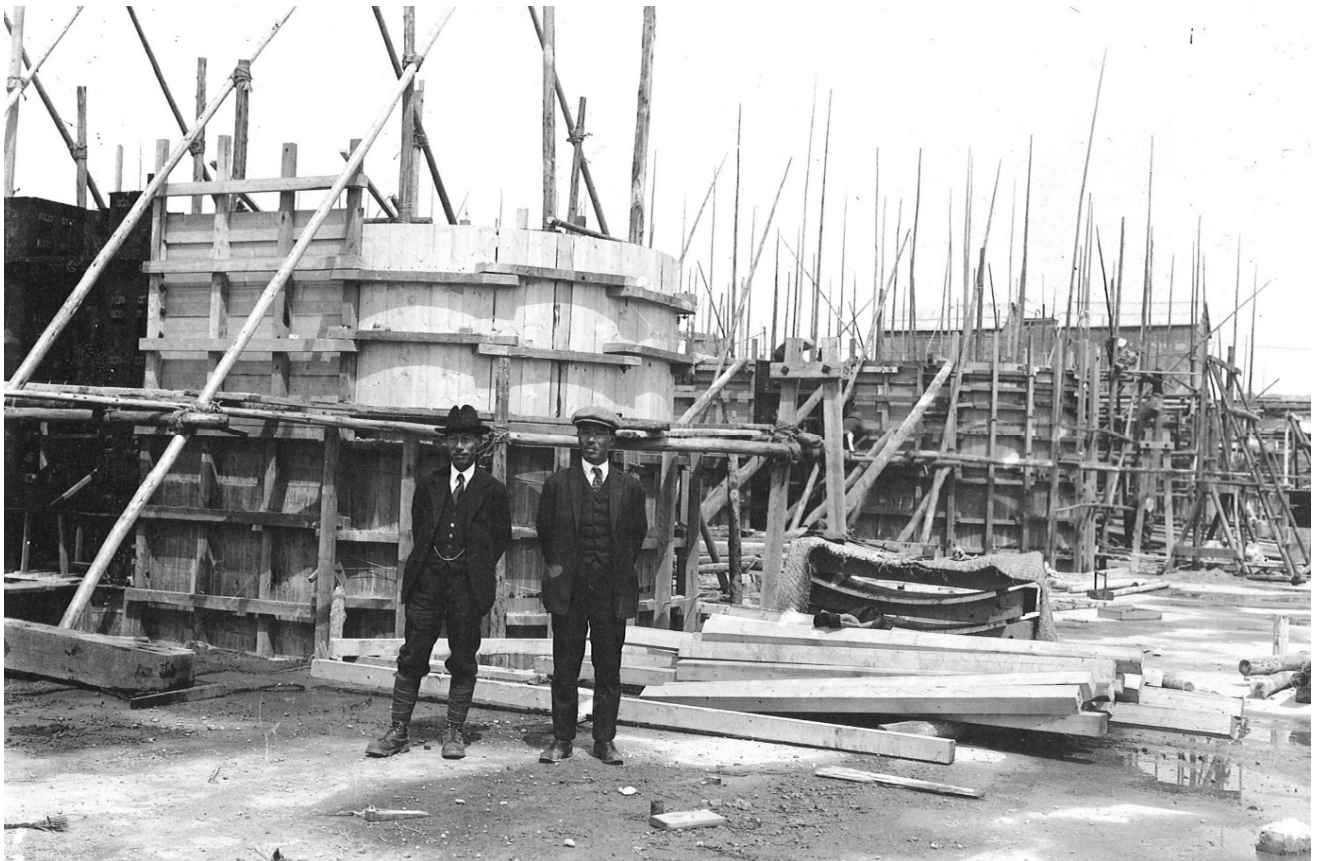
可動堰堰柱型枠の前で記念撮影 青山士（左）と宮本武之輔（右） 1930（昭和5）年4月23日撮影
