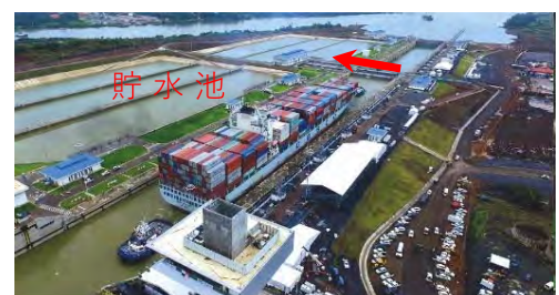
ローラーゲート式閘門
