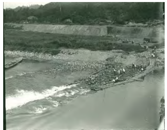
川底を補強する大河津分水 石港の床留工事
