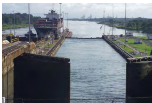
パナマ運河の 開閉式閘門 (マイターゲート)
