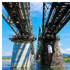
信越本線越路橋梁 (新潟県長岡市)
