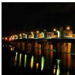
妙見堰 (新潟県長岡市)
