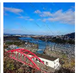
信濃川発電所 (新潟県小千谷市)
