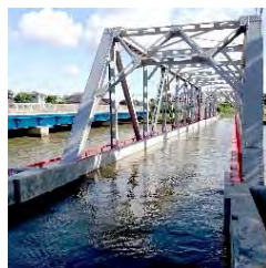
新川西川立体交差 (新潟県西区)
