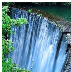
大源太川第一号砂防堰堤 (新潟県湯沢町)
