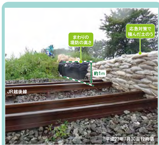
まわりの堤防をかさ上げて現在の高さになった時期よりもJR越後線が造られた時期の方が古い ため、まわりの堤防よりJR越後線が約1m低くなっています。
