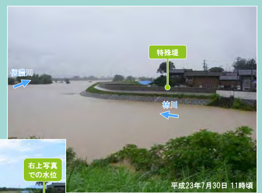
柿川が信濃川へと合流する付近で、右岸側から下流方向を撮影。この場所は、平成22年度に河川改修が行われた場所で、コンクリートで出来た特殊な堤防(特殊堤)などを整備しました。
