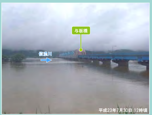
信濃川に架かる与板橋を右岸から撮影。信濃川が増水し、河川敷が見えなくなりました。また、川幅いっぱいになり水が流れています。
