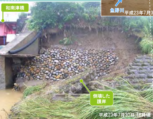
魚野川に架かる和南津橋の橋台取付部分(魚野川右岸側・上流側)にあるコンクリートブロック積が、洪水の激しい勢いで壊れました。
