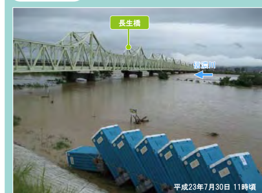
信濃川に架かる長生橋を左岸側から撮影。長岡祭りの花火会場として準備中でしたが、河川敷まで水に浸かり、仮設トイレなどが流されました。
