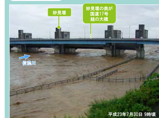
妙見堰・国道17号越の大橋付近を右岸側から撮影。妙見堰の手前に見える転落防止柵が濁流にのみ込まれるほど水位が上昇しました。
