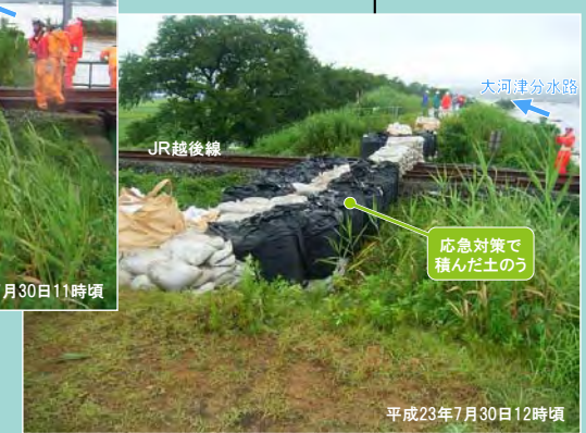
燕市と長岡市の水防団、水防活動支援の要請を受けた国土交通省信濃川河川事務所が協力し、クレーンなどを使い土のうを積み作業を行いました。
