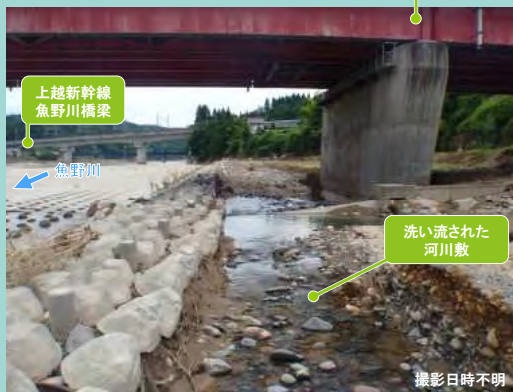
魚野川に架かる和南津橋の下、上流に向かって撮影。 河川敷が洪水の激しい流れにより洗い流されました。
