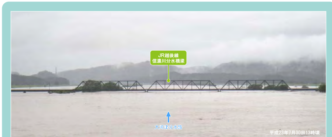
大河津分水路に架かる国道116号大河津橋の上から上流方向に向かって撮影。 川幅いっぱいに水が流れ、JR越後線信濃川分水橋梁の橋桁にもうすぐ水が届きそうな状況でした。
