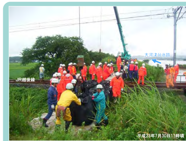
燕市と長岡市の水防団、水防活動支援の要請を受けた国土交通省信濃川河川事務所が協力し、クレーンなどを使い土のうを積み作業を行いました。
