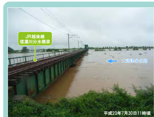
左岸側から撮影。 水位が上昇し、JR越後線信濃川分水橋梁の橋桁すれすれを濁流が流れていきます。
