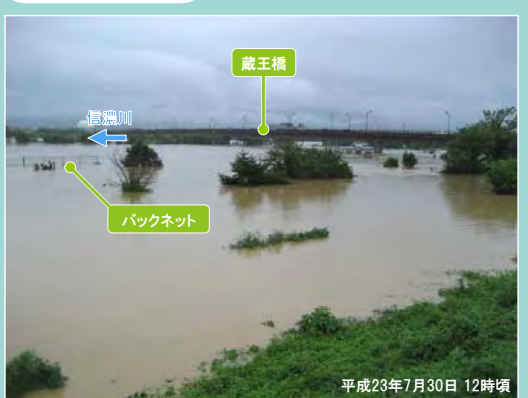
信濃川に架かる蔵王橋を左岸側から撮影。河川敷にある長岡市民スポーツ広場が水に浸かっている状況。野球場のバックネットが水に浸かっています。
