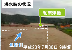
和南津橋 魚野川 平成23年7月30日 9時頃
