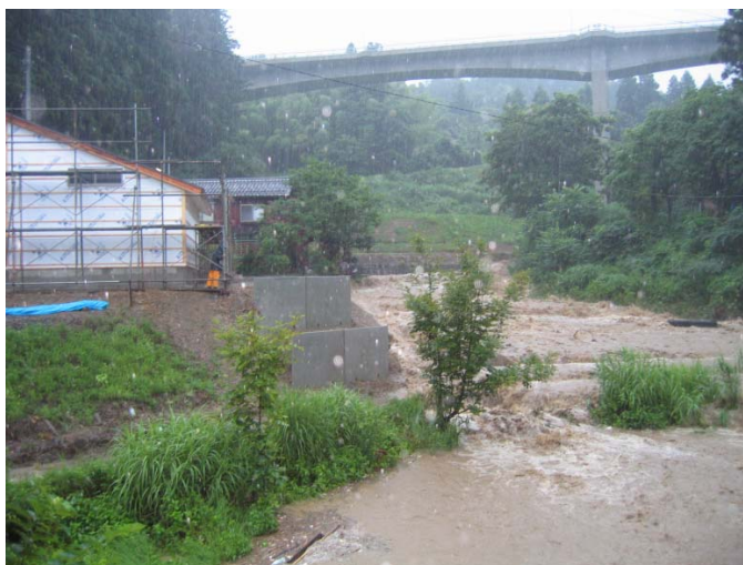
地すべり前。建設中の納屋の奥に家屋が見える。
