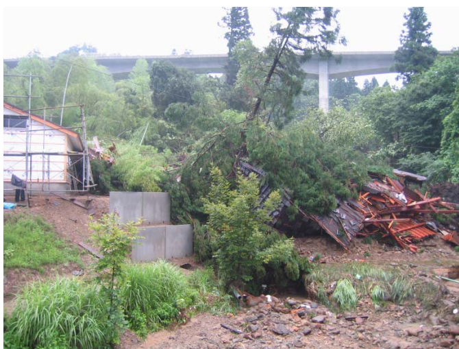
地すべり後。家屋は土砂に押しつぶされた。
