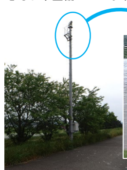
CCTVカメラ設置状況
