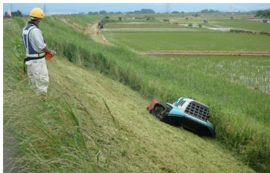
堤防除草作業状況
