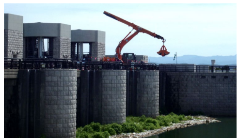
大河津洗堰 漂着流木等の撤去状況
