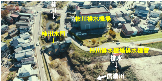
柿川排水機場
