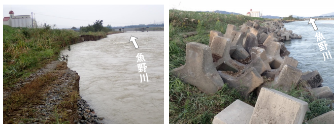
応急対策実施前（魚野川の被災状況） 応急対策実施後（ブロックの投入）
