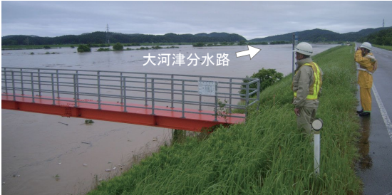
出水時巡視状況（大河津出張所管内）
