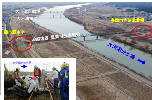
水防活動の状況（右岸側） (R元年台風第19号時)
