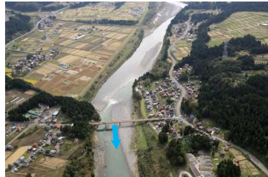
写真 2-3 信濃川 姿大橋付近 (十日町市)
