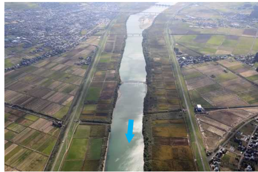
写真 2-6 大河津分水路 新長床留付近 (燕市)
