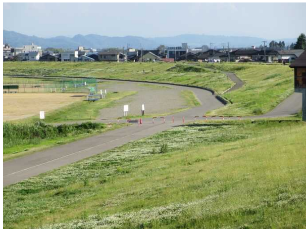
写真 2-8 緩傾斜堤（長岡市緑町地先）
