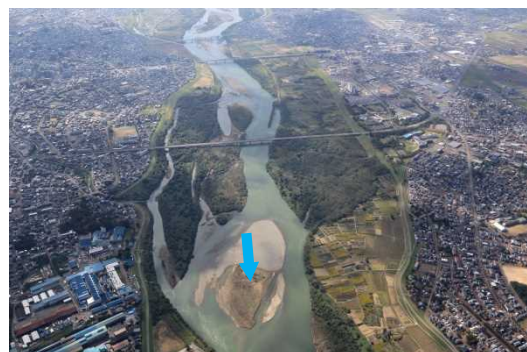
写真 2-5 信濃川 国道8号 長岡大橋付近 (長岡市)
