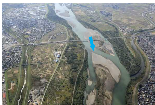
写真 3-1 高水敷の樹林化 (長岡市内 フェニックス大橋周辺) (平成 28 年 10 月撮影)
