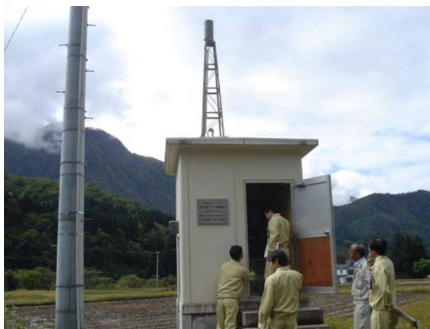
写真-6-4 水文観測所点検（五十沢雨量観測所）
