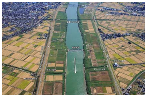
写真-2-5 大河津分水路 新長床固付近 (新潟県燕市)
