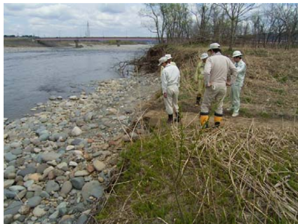
写真-6-5 安全利用点検（十日町出張所管内）
