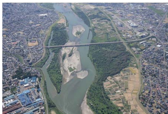
写真-3-1 高水敷の樹林化 (長岡市内 長岡大橋付近) (平成 18 年 9 月撮影)
