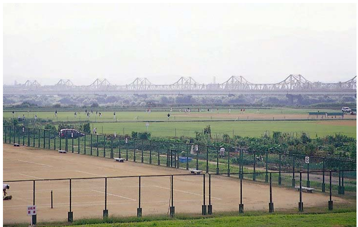
写真-2-7 信濃川河川公園（長岡市緑町地先）
