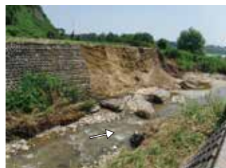
被災状況(信濃川支川悪沢川)
