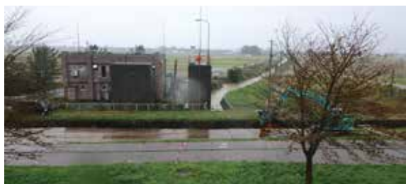
島崎川排水機場
