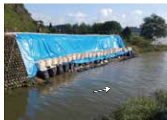
応急対策実施後
