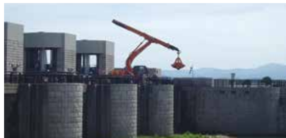
大河津洗堰 漂着流木等の撤去状況
