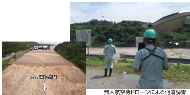
無人航空機ドローンによる河道調査
