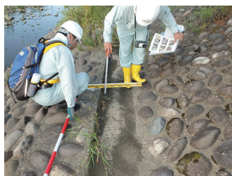
堤防等点検（護岸）
