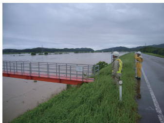
出水時巡視（大河津出張所管内）
