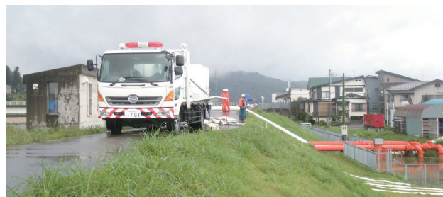
排水ポンプ車による排水状況
