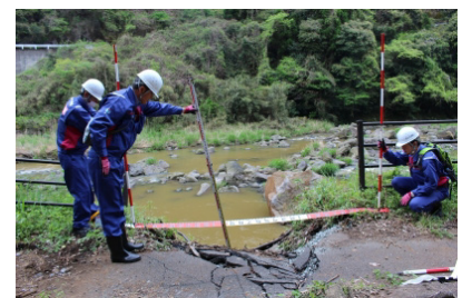
平成28年4月熊本地震(熊本県) 阿蘇市の被災状況調査
