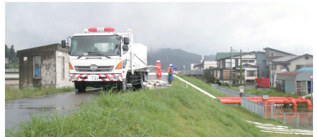
排水ポンプ車による排水状況
