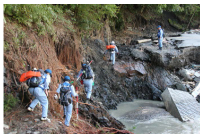
平成28年8月台風10号(岩手県) 河川の被害箇所調査
