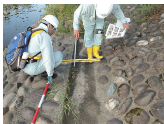
堤防等点検(護岸)
