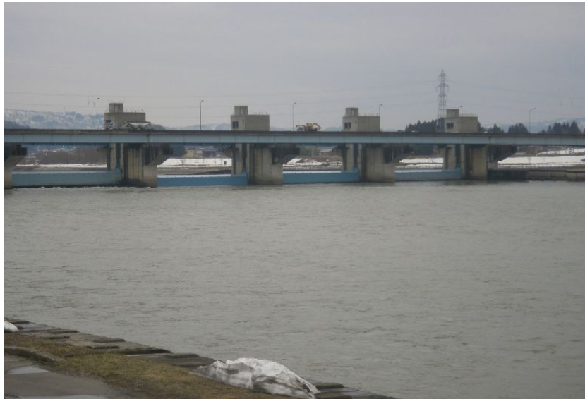
妙見堰ゲート付近
