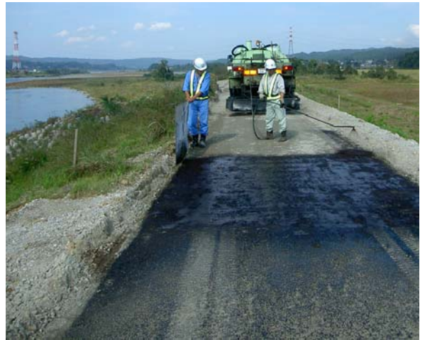
人力による乳剤散布状況
