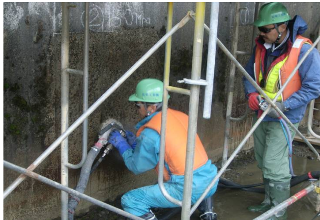
ウォータージェット試験施工実施状況
