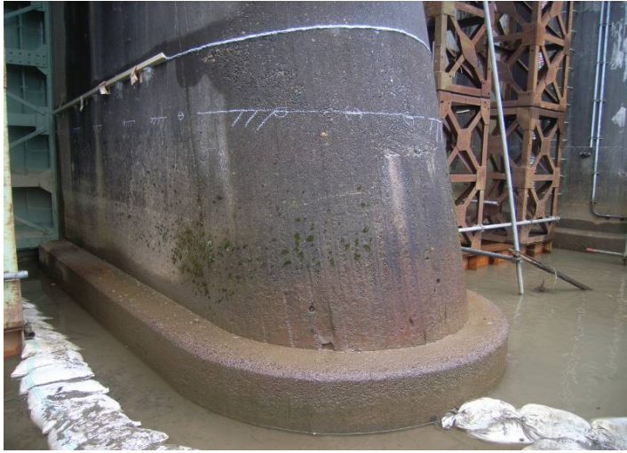
施工前（水門橋脚部）
