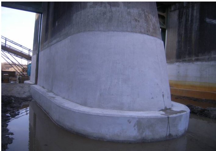
断面修復ポリマーセメント吹付け完了
