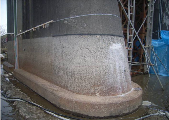
WJ表面処理施工後
