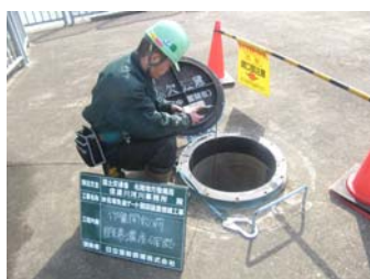
作業開始前酸素濃度測定状況
