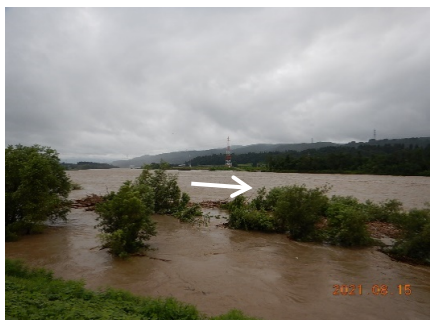
出水時 (2021/08/15 16:49 ほくほく線橋梁上流付近)
