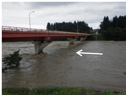
出水時 (2021/08/15 17:43 姿大橋上流付近)
