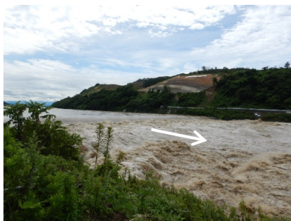
出水時 (2021/08/16 10:23 第二床固付近)
