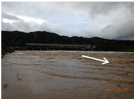
出水時 (2021/08/15 17:36 宮中取水ダム付近)
