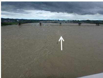
出水時 (2021/08/15 15:38 越路橋下流付近)
