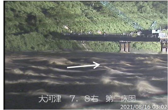
出水時 (2021/08/16 03:02 第二床固付近)
