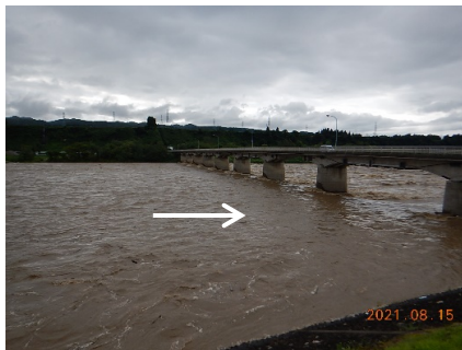
出水時 (2021/08/15 16:38 十日町橋上流付近)
