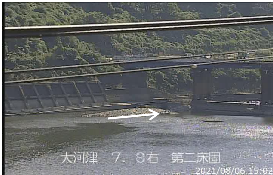
平常時 (2021/08/06 15:02 第二床固付近)
