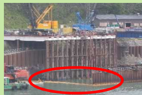
シルトフェンス (汚濁防止膜) の設置
