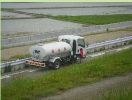
工事用道路への散水 (粉塵等抑制)
