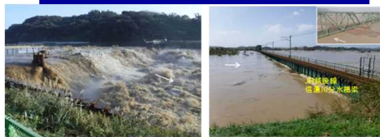
第二床固副堰堤付近の状況（令和元年10月13日16時頃） JR越後線信濃川分水橋梁付近の状況（令和元年10月13日12時頃）
