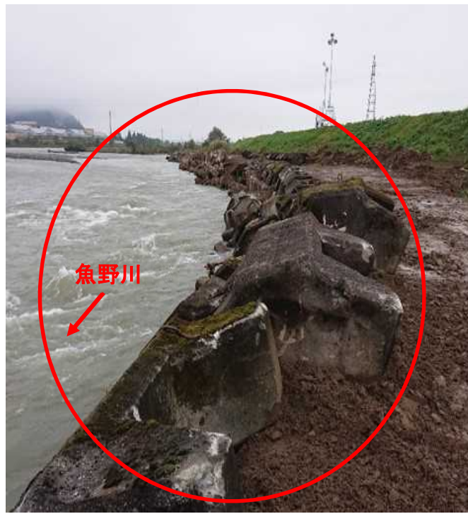
応急復旧完了
