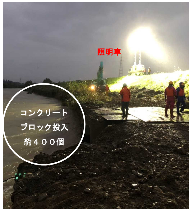
応急復旧着手
