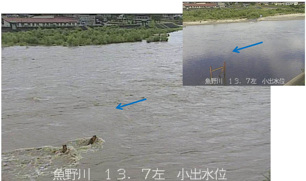
小出橋上流 左岸側より魚野川の状況 令和元年7月28日7時頃撮影(右上は27日14時30分頃撮影)
