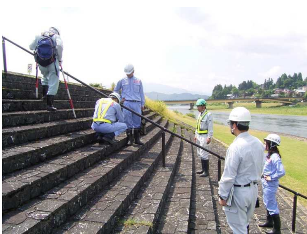
平成28年6月 安全利用点検状況(堀之内出張所)
