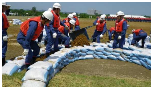
水防訓練（月の輪工法）の様子
