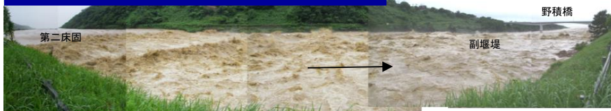
流下能力が不足し、抜本的な改修が必要な大河津分水路
