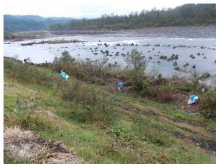
馬場堤防付近作業風景①
