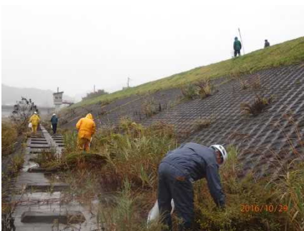
西川口堤防付近（長岡市西川口地先）作業風景②
