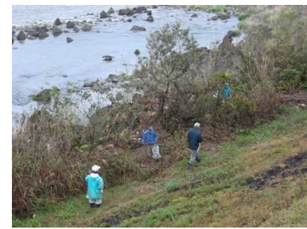
馬場堤防付近作業風景②
