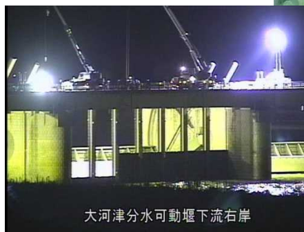
排水ポンプ車による排水作業
