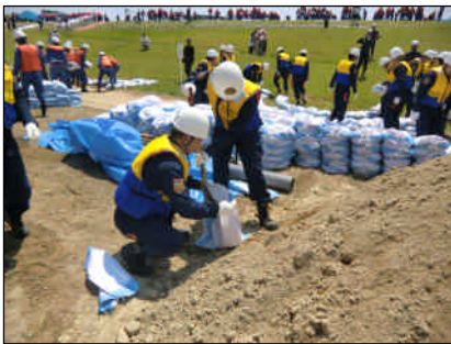
堤防の漏水を防ぐ月輪工法
