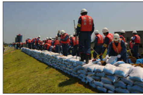
川の水が堤防を越えることを防ぐ積み土のう
