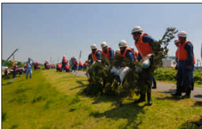
堤防が崩れることを防ぐ木流し工法
