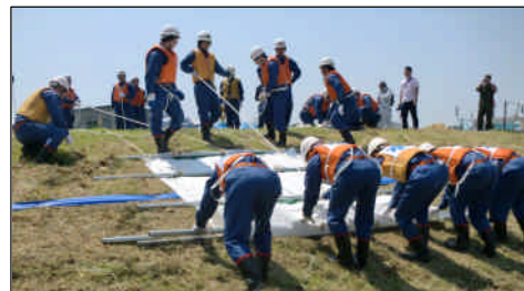
堤防が崩れることを防ぐシート張り工法
