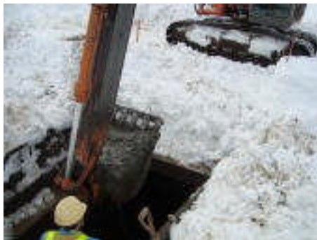
川口消流雪用水施設呑口部土砂撤去(H24.1.17)
