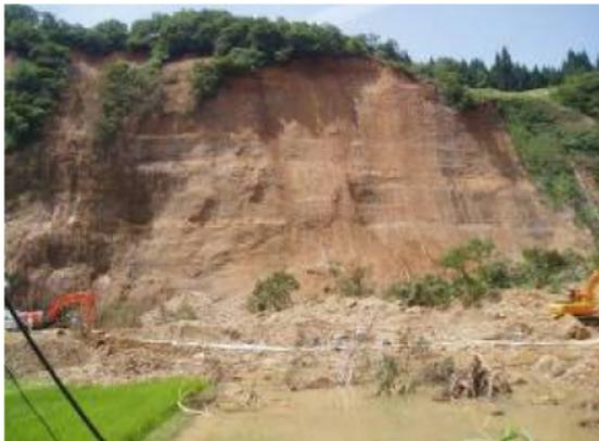
【バックホウによる堆積土砂の掘削状況】
