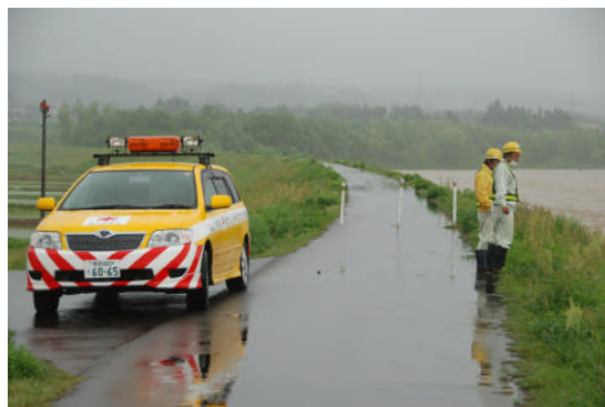
十日町出張所管内の巡視状況(5月30日) 堤防天端から護岸の状況を確認中
