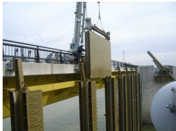
②予備ゲート吊り落とし
