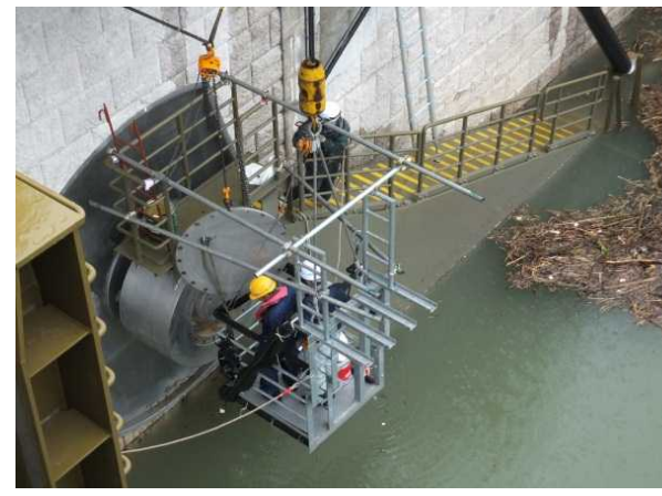
④-3 ゲート本体（回転軸）の点検
