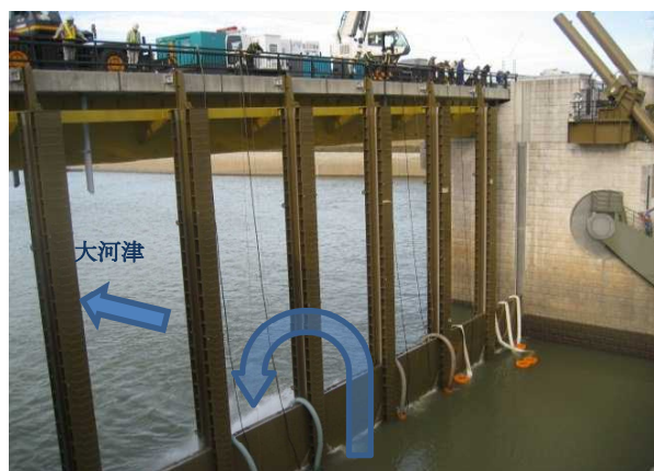
③排水作業
