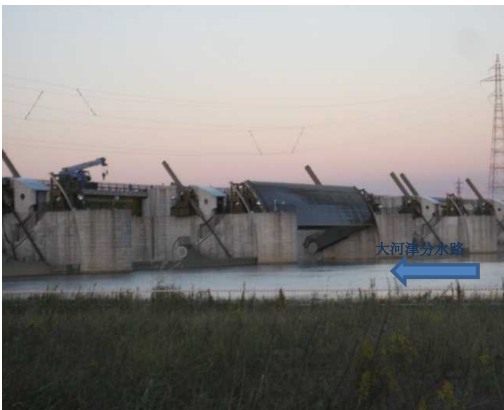
⑤ゲート全開操作確認
