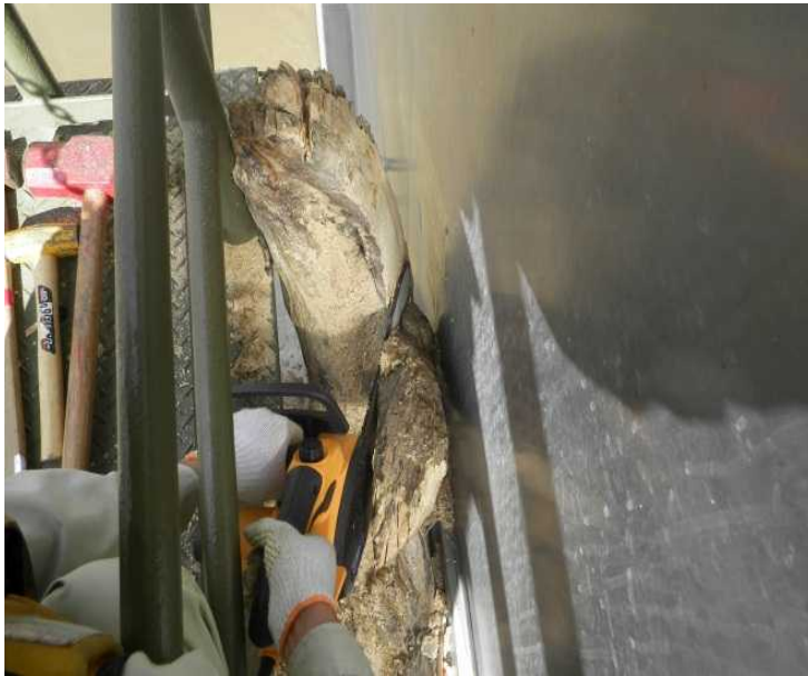
④-4 隙間部障害物の除去
