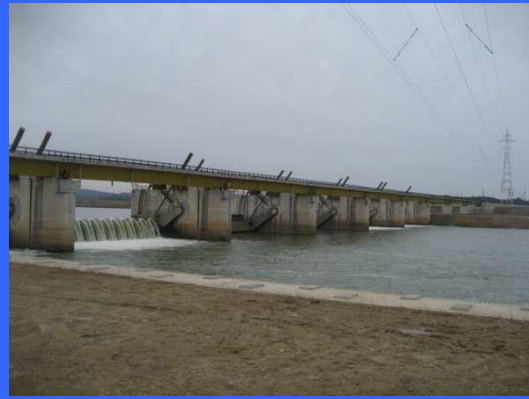
③ 右岸仮締切りより
