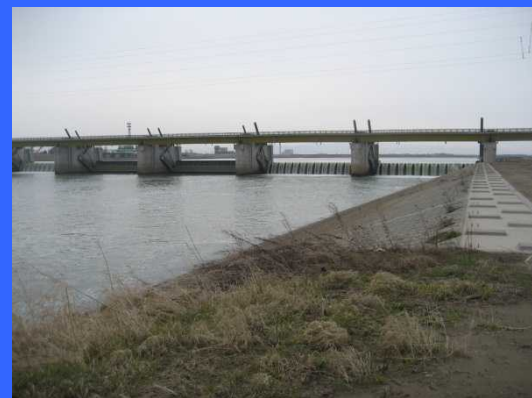
④ 左岸魚道下流より
